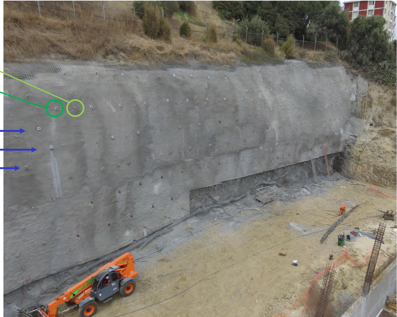
Obra de Contención para Edificio 2B UNAB, Viña del Mar, Chile
