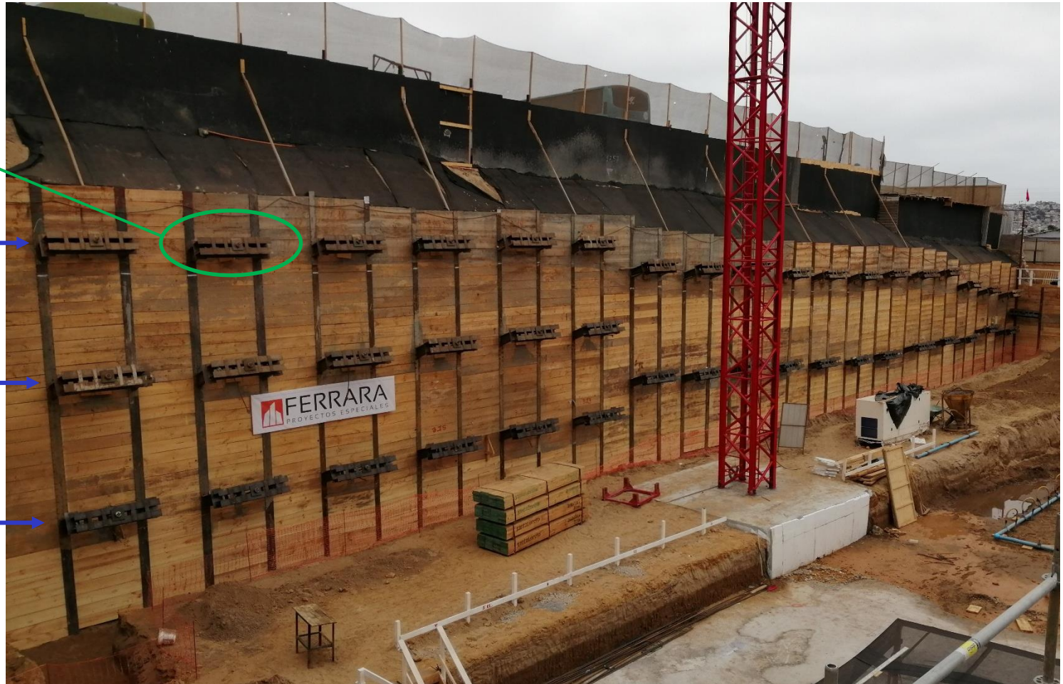
Obra de Contención para Edificio Santa Rosa del Mar, Coquimbo, Chile Diseñada y ejecutada por Ferrara
