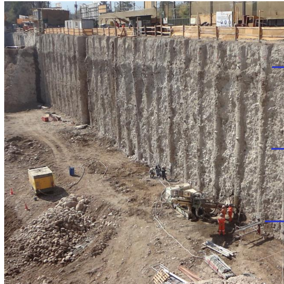
Obra de Contención para Edificio Parque San Damián, Santiago, Chile Diseñada por Ferrara
